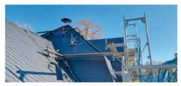
Die anspruchsvolle Dachkonstruktion mit unzähligen Kehlen und Graten sowie Dachteilflächen in unterschiedlichsten Neigungen erforderten handwerkliches Geschick und kleinteiliges Können.
