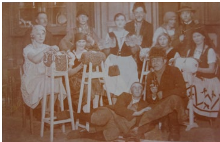
Aufführung in der Gaststätte „Reitschule“, „In der Hutzenstube“
